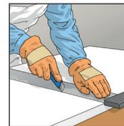
3. Klimaplatte mit Cutter anritzen und über Kante brechen oder mit einer Säge zuschneiden.
